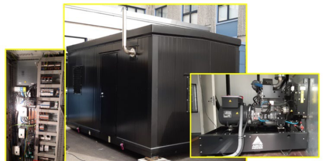
Kuva 10. Hybridilaboratorion varavoimageneraattori
