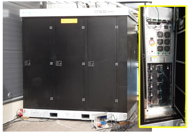
Kuva 9. Li-Ion-sähköakkuvarasto
