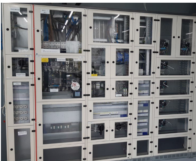
Kuva 1. Hybridilaboratorion jakokeskus
