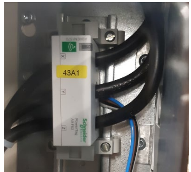
Kuva 2. Jakokeskuksessa oleva langaton virtamuuntaja
