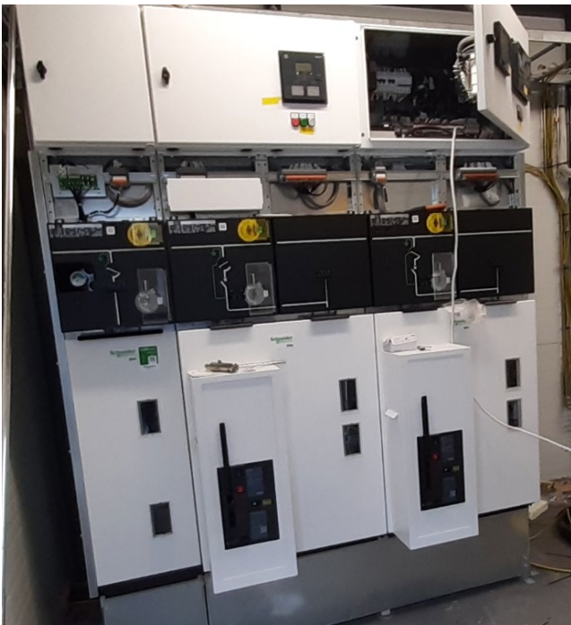
Kuva 12. 20 kV:n keskijännitekojeisto
