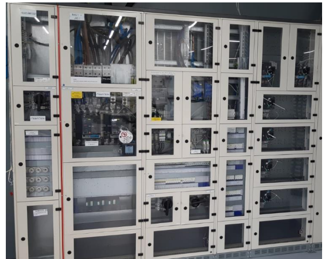
Kuva 1. Hybridilaboratorion jakokeskus
