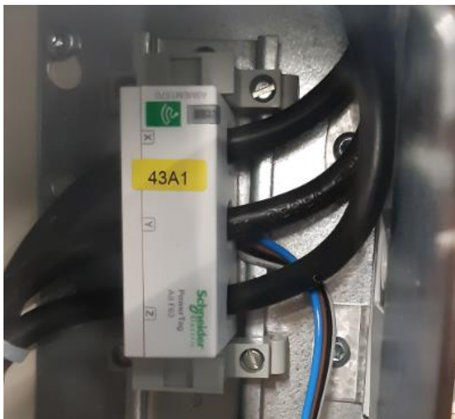
Kuva 2. Jakokeskuksessa oleva langaton virtamuuntaja
