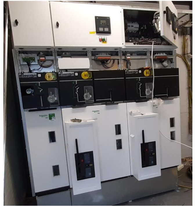
Kuva 12. 20 kV:n keskijännitekojeisto
