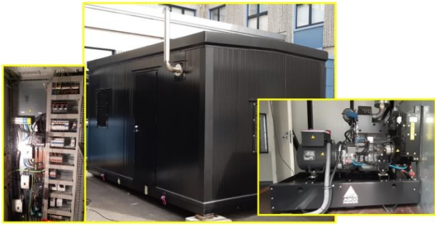
Kuva 10. Hybridilaboratorion varavoimageneraattori
