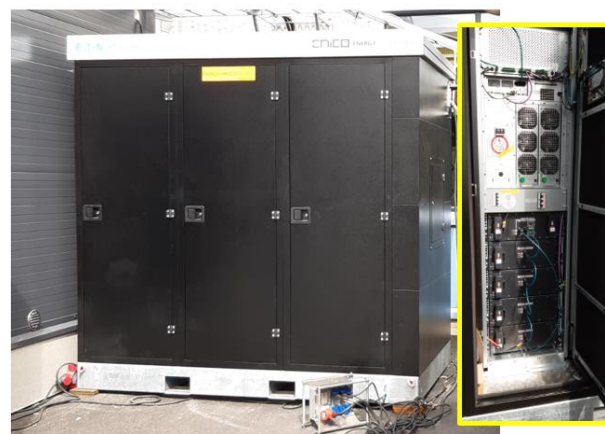
Kuva 9. Li-Ion-sähköakkuvarasto
