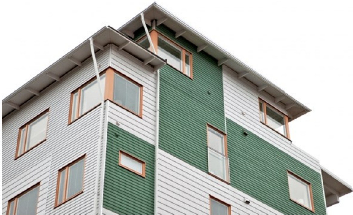
Picture 4: Source: trastad.se Älvsbacka strand, Skellefteå.
