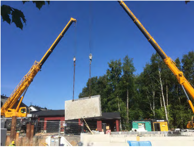
Kuva 1. Sandwich-elementin asennusnosto kahdella nosturilla. Kahden nosturin nostot ovat aina erikoisnostoja ja vaativat lisäksi erillisen nostosuunnitelman kirjallisena.
