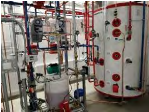
Aurinkokeräinten kiertojärjestelmät ja energiavaraaja (Leskelä 2021)
