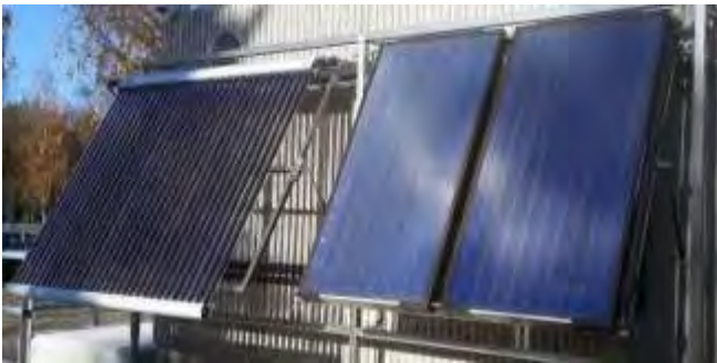
Oamkin hybridilämpöjärjestelmän aurinkokeräimet (Mielityinen 2021)
