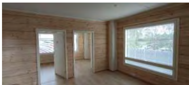
Pilari-palkki-laattarungolla toteutettu Pudasjärven Hirsihovi (Pariainen 2021)
