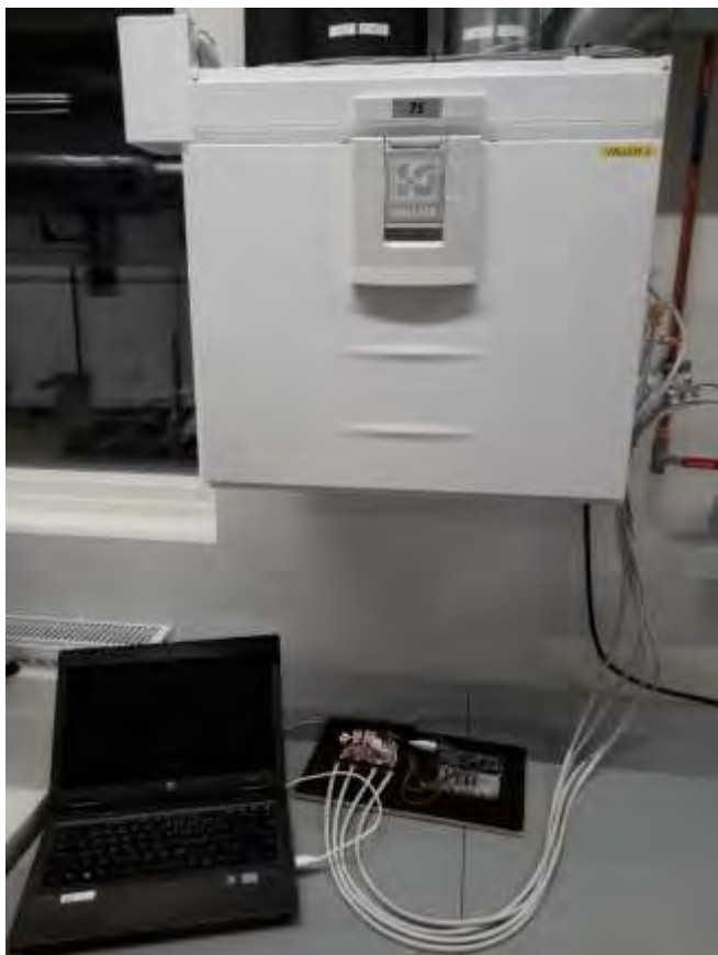
Ilmanvaihtokoneen lämmönvaihtimen hyötysuhteen mittausjärjestely
