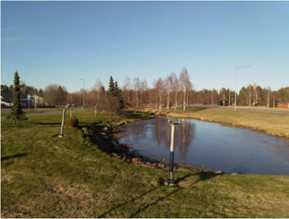
Hulluojan hulevesialtaan virtaama on nykytilassa heikkoa ja altaassa on voimakasta leväkasvua.
