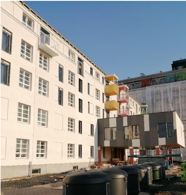
Rave Rakennuksen työmaa Tervahovin Mylly Oulussa.
