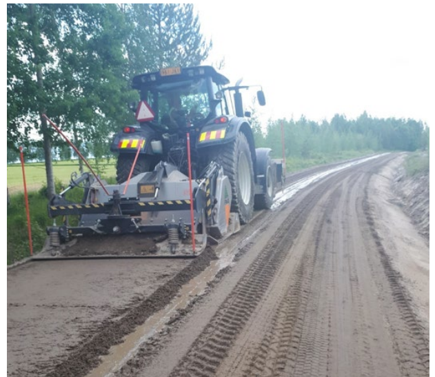
Traktorin perässä oleva laite jyrää, sekoittaa, tasoittaa ja tiivistää tienpinnan.
