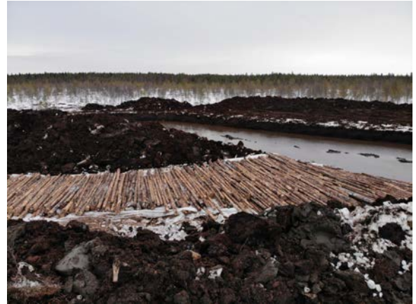
Vesiensuojelurakenne rakennusvaiheessa maaliskuussa 2020. Kuva: Titta Järveläinen
