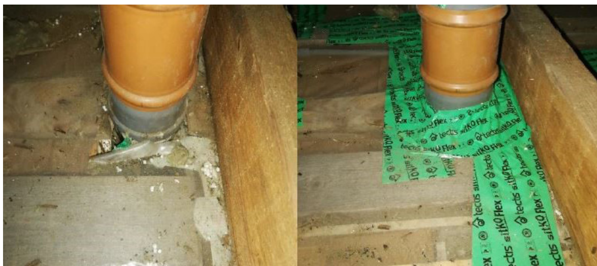
Viemärintuuletusputkien läpiviennit teipattiin ja puhdistettiin.
