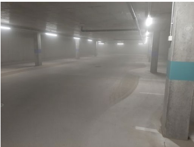
Kuva 1. Parkkihalliin kertyy autojen renkaista pölyä
