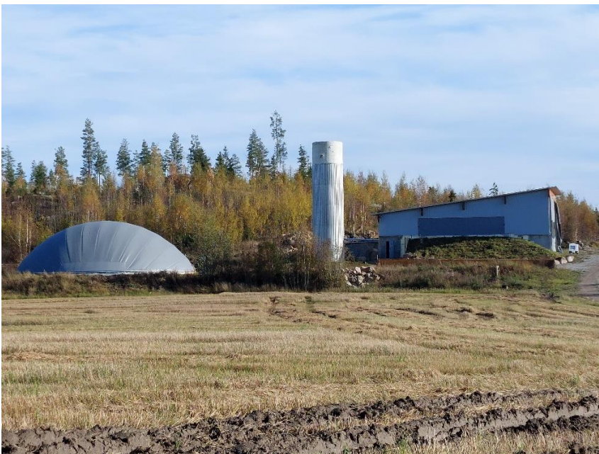
Kuva 9 Alangon tilan biokaasulaitos. Vasemmalla kaasuvarasto, keskellä perkolaationestesäiliö ja oikealla reaktorihalli
